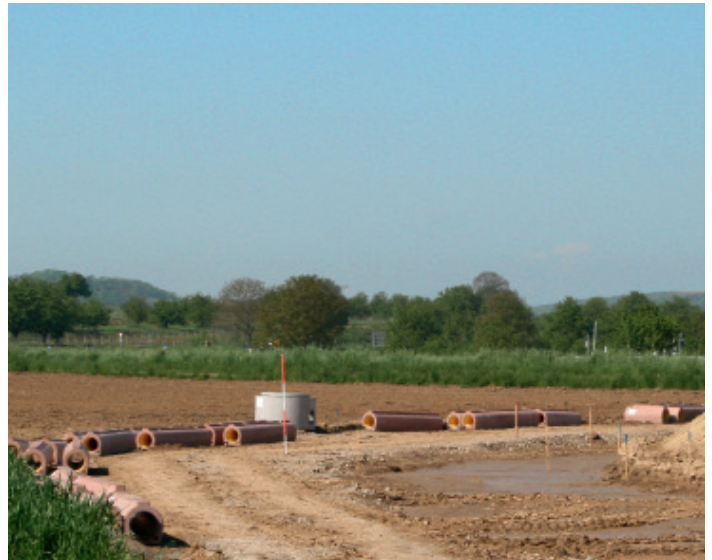
Rohr- und Schachtmaterial stehen vor der malerischen Kulisse des Kaiserstuhls bereit zum Einbau.
