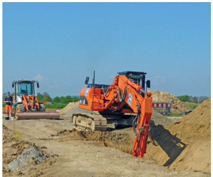
Der Einbaufortschritt begeistert die Verantwortlichen auf Auftraggeberseite ebenso wie jene im Ingenieurbüro und bei der Baufirma
