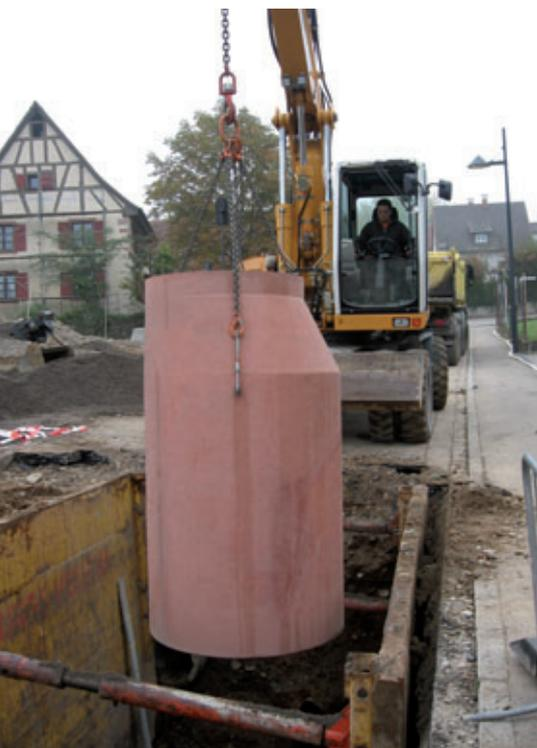
*Perfect-Schachtaufbauten werden im Betonwerk Müller für individuelle Aufbauhöhen von 0,20 bis 2,10 Meter gefertigt. Als Einstiegsöffnung ist eine lichte Weite von 625 oder 800 Millimetern vorgesehen.*
