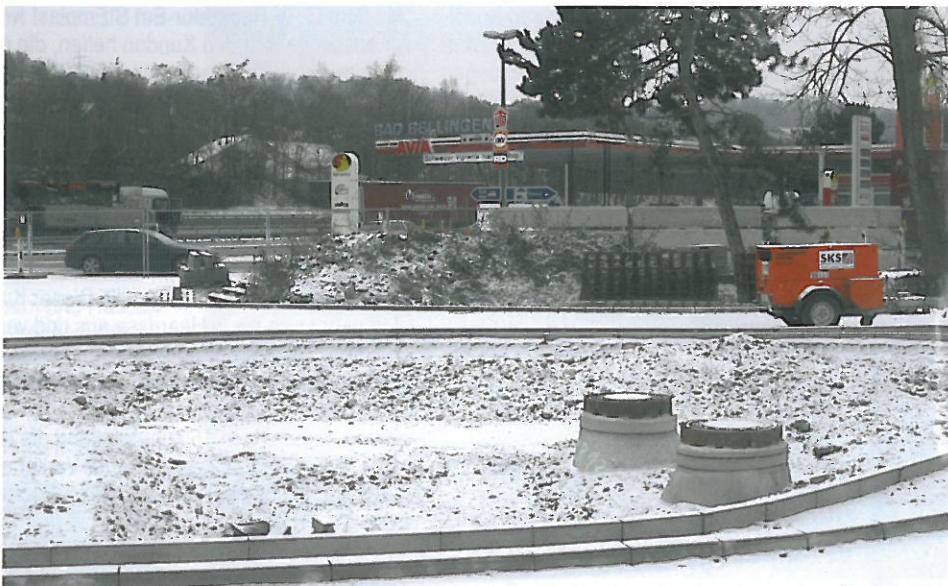
Die Rastanlage Bad Bellingen unmittelbar vor Fertigstellung - 62 Lkws können künftig hier sicher abgestellt werden. Fotos (3): BBMG-ARCHIV
