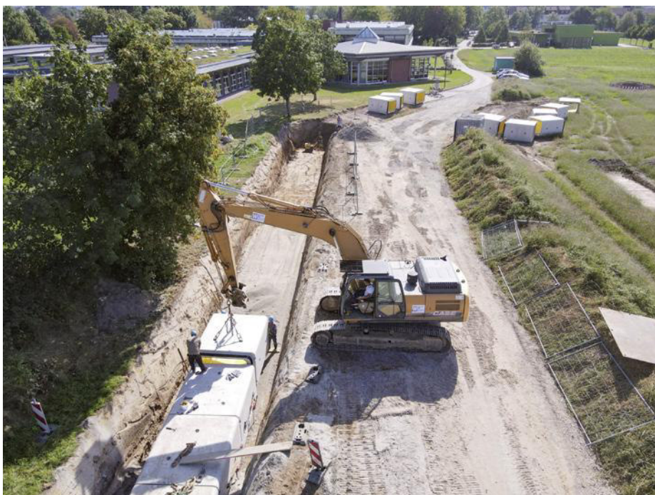
Die Verlegung der Rahmenprofile verlief schnell und problemlos. | Foto: Beton Müller
