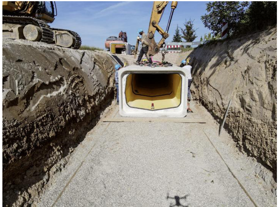
Die geringere Bauhöhe gegenüber einem runden Rohr mit vergleichbarem Stauvolumen war bei der geringen Tiefenlage des neuen Kanals eines der Argumente für die Perfect Box. | Foto: Beton Müller
