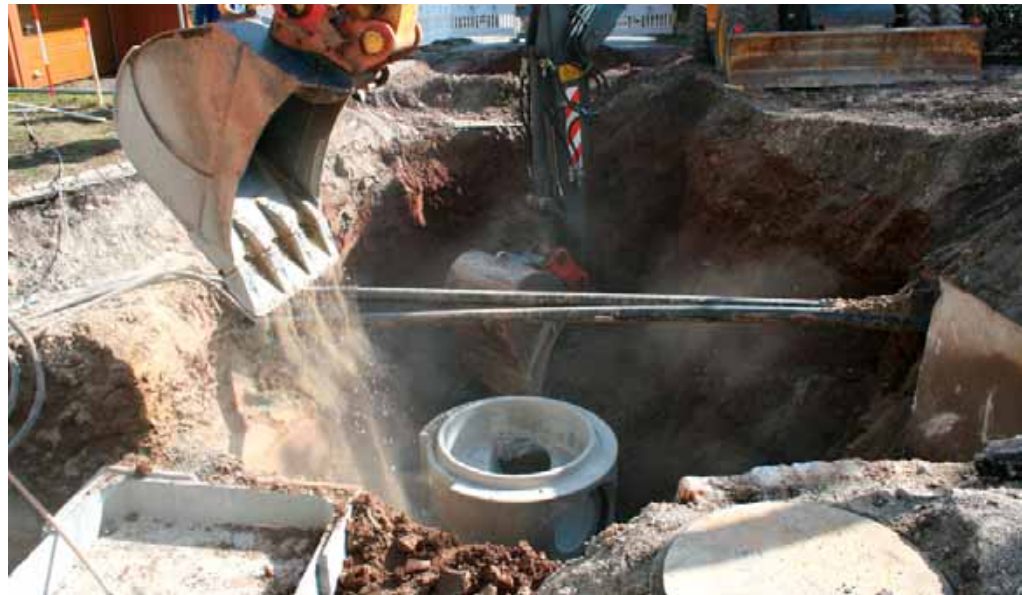
Monolithische Betonschachtunterteile halten auch typisch „rauen“ Einsatzbedingungen problemlos stand
