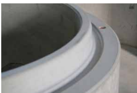
Hochqualitative Oberflächen der Betonfertigteile – im Bild die umlaufende Nut zur Aufnahme des Tok-Seal-Sandschlauchs
